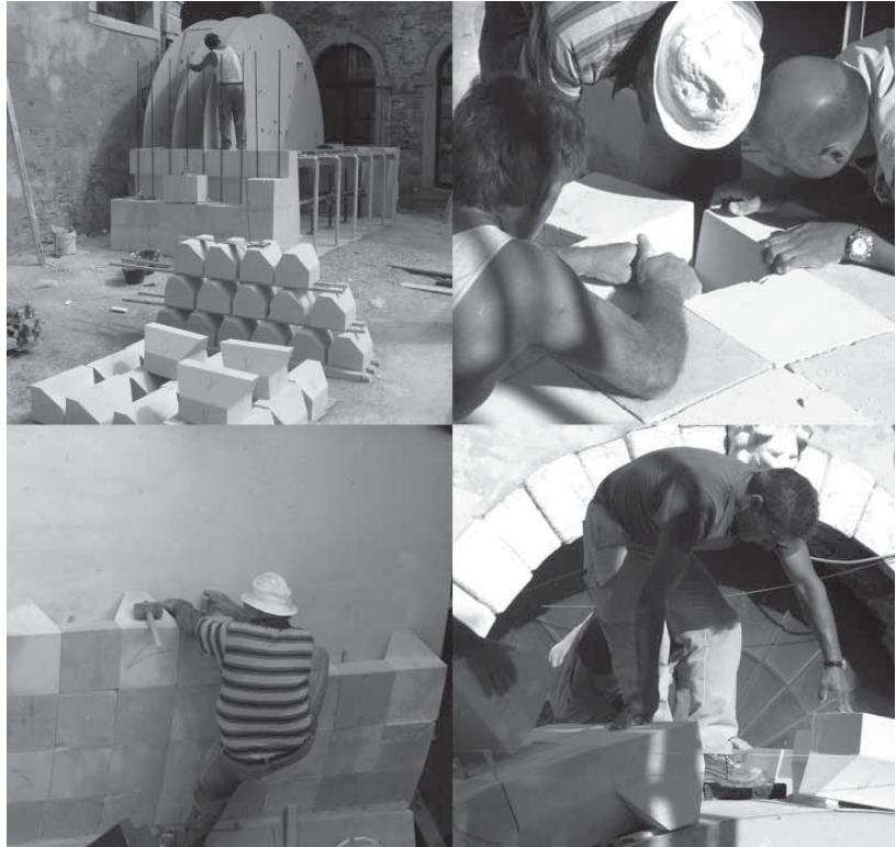
Figura 79. Fasi di montaggio della volta “Abeille” all’ingresso della mostra Città di Pietra (Venezia 2006). Assembling phases of “Abeille” vault at the entry gate of Città di Pietra (Venice 2006).
